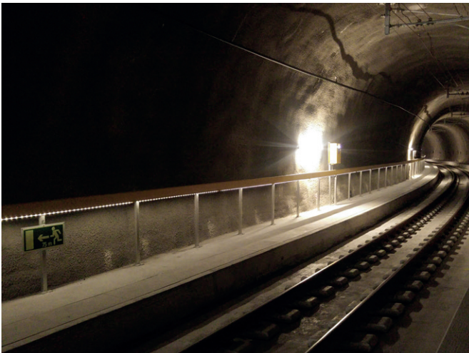
Installazione galleria Ruckhalde Appenzeller Bahnen
